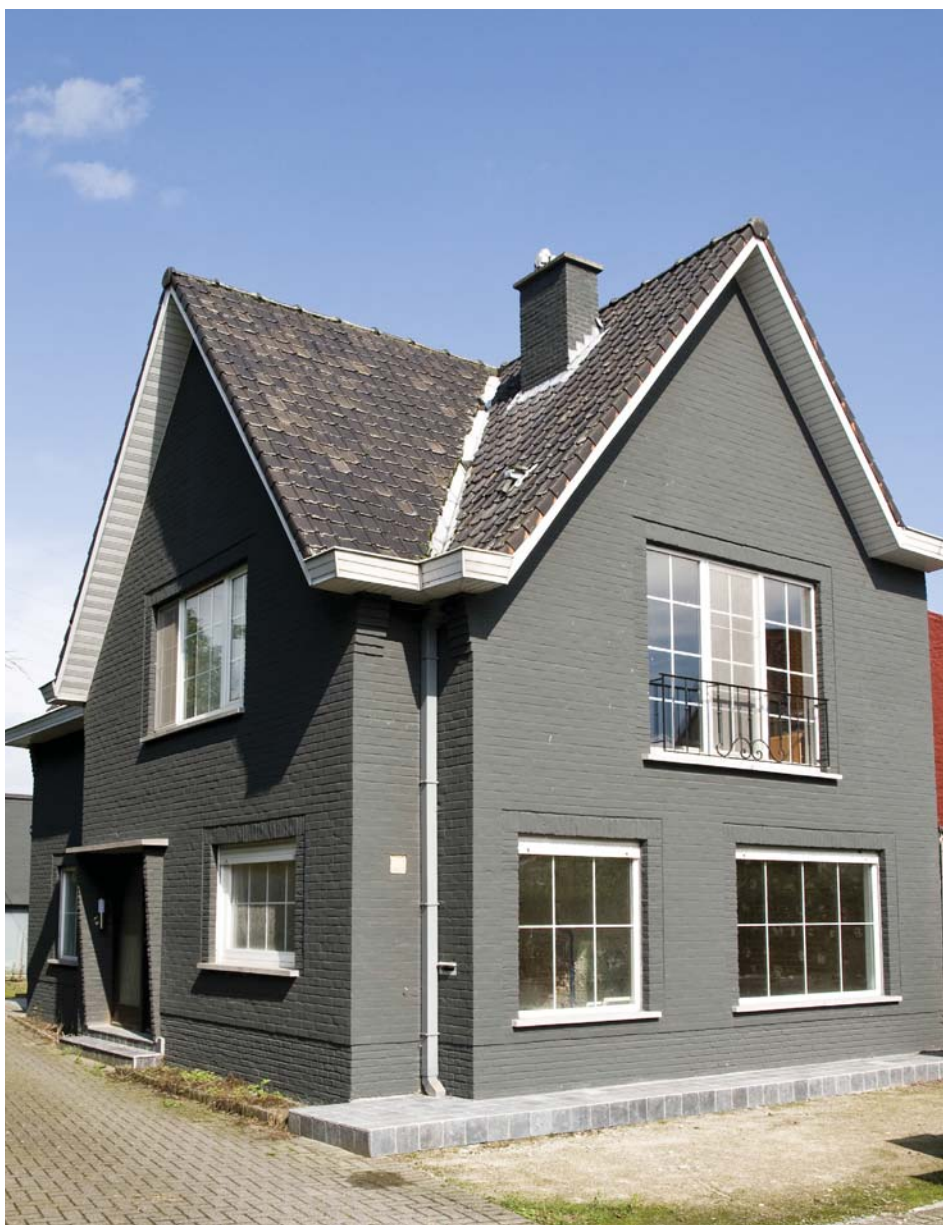
Rénovation habitation à Merelbeke, BE
