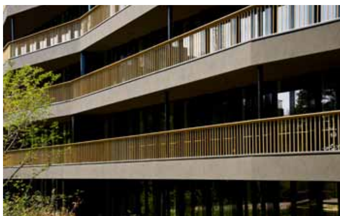
Parc Hamoir, Bruxelles, Belgique Architecte : ELD Partnership, Anvers, Belgique
