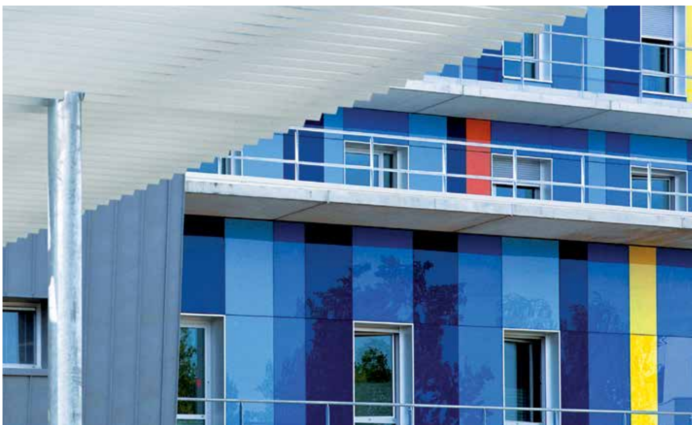
Pôle hospitalier Femme-Mère-Enfant, Le Mans (France) Architecte: AIA architectes, Nantes (France)
